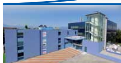
ROVER - Ingresso uffici e laboratori
